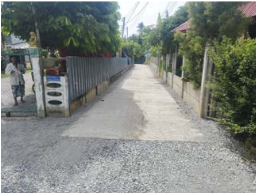
โครงการก่อสร้างถนนคสล.ซอย๑๐ จากถนนโพธิ์พระยา - บ้านกล้วยถึงบริเวณบ้านนางชด อุ่นเรือน หมู่ที่ ๖
