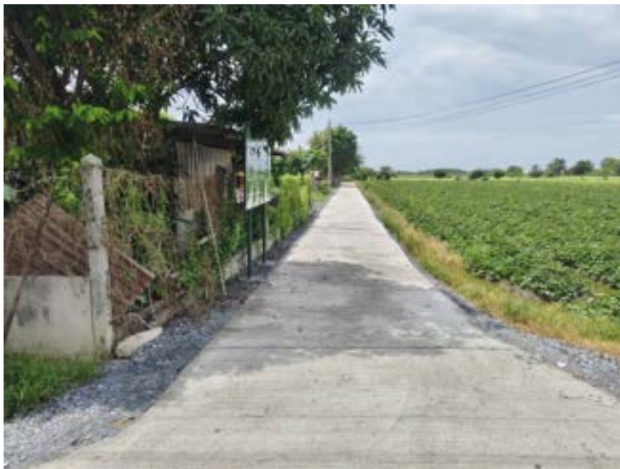
โครงการก่อสร้างถนน คสล.จากบ้านนายสมชาย อ่อนทิมวงศ์ถึงบ้านนายเกรียง พุ่มเกษร หมู่ที่ ๒
