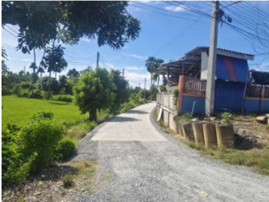
โครงการก่อสร้างถนน คสล.ซอย๑๐จากถนนโพธิ์พระยา - บ้านกล้วยถึงบริเวณบ้านนายโสภานี้มนวล หมู่ที่ ๓
