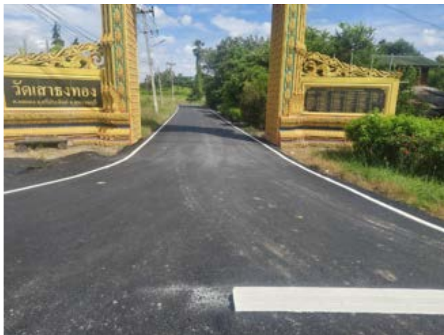
โครงการเสริมผิวจราจร Asphalt Concrete สายทางเข้าวัดเสาธงทองหมู่ที่ ๒ (ช่วงที่ ๑ )
